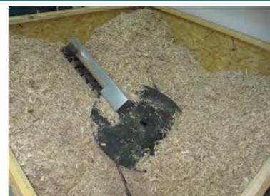
La forma del locale per lo stoccaggio di cippato è solitamente quadrata, con i lati da 2 m a 4 m, mentre la lunghezza della coclea può raggiungere dai 2,5 m agli 8 m. Al di sotto della coclea il locale deve possedere un suolo in legno e una base rotante a molle. Tali serbatoi possono essere installati nelle caldaie più piccole fino alle più grandi alimentate a
