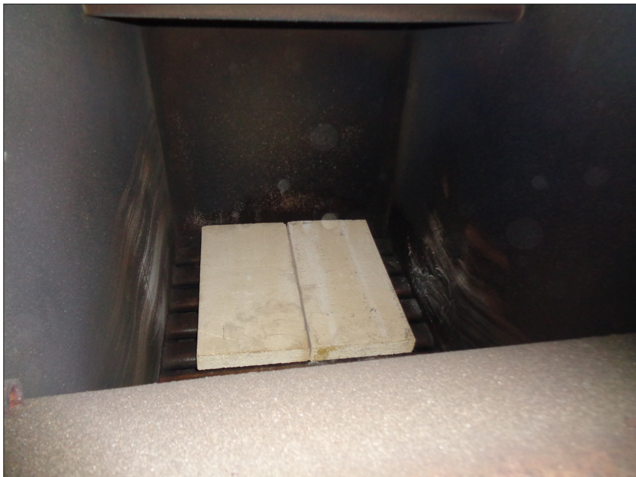
Slika 5: Položaj šamotnih ploča na vrhu rešetke u ložištu.
